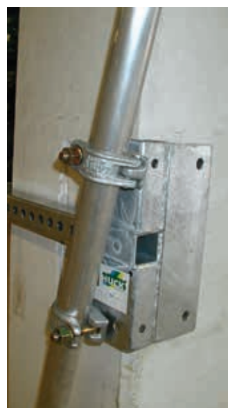
Typ (C) + (D) zajištění okrajů střechy
