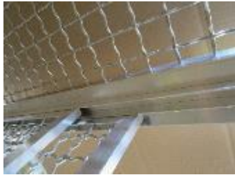
Vodící lišta posuvných dveří v horním dílu
