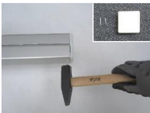
Montáž krytu hranatých sloupků:
