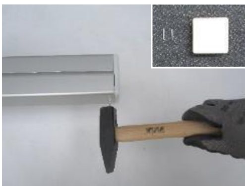
Montáž krytu hranatých sloupků:
